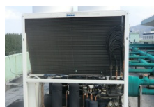
清洗空调散热片
